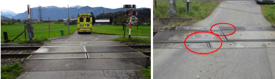
Figure 11-2: fentes dans la zone de PN, angle minimal
